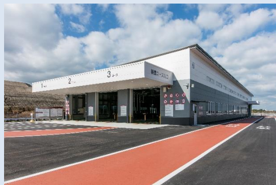
検査棟完成写真
