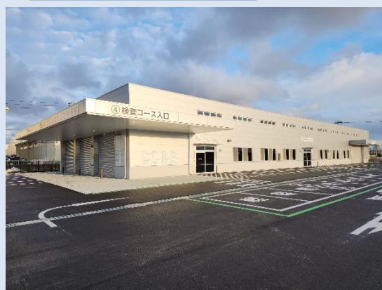
検査棟完成写真
